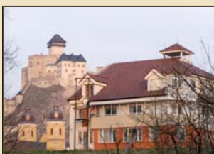
5-podlažná budova s podkroviem v Trenčíne. Výstavba r. 2003, železobetónový skelet s murovanými výplňami. cena: info v RK 0915/808514
