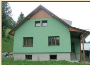
Penzión v Zázrivej pred dokončením, zateplený, sedlová strecha. 8 izieb po 2 lôžka (v každej izbe je sprchový kút + WC), spoločenská miestnosť, kuchynka. cena: dohodou 0915/808511
