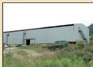
Oceľová hala v Ružomberku vhodná na výrobu, alebo sklad 18m x 60m. Kolažový žeriav 3,5 t. Elektrina 230, 400 V. Dobrý prístup. Predaj alebo prenájom. cena: dohodou 0915/808512
