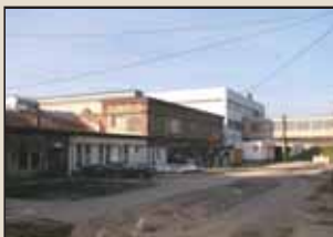
Výrobné priestory v Žiline, so samostatným vstupom. Budova je dvojpodlažná, zast. plocha 3200 m 2 . Voda, elektrina, ústredné kúrenie. cena: info v RK 0915/808 514
