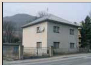
Dom v Tisovci je podpivničený s dvoma nadzemnými podlažiami. Prízemie pozostáva z prevádzkovej časti. Poschodie je jedna obytná jednotka. cena: info v RK 0915/808514
