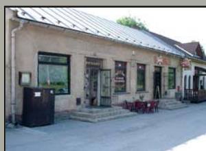
Obchodné priestory na Rosinkách sú vhodné aj pre drobnú výrobu, majú samostatný vchod, vykurovanie, parkovanie, možnosť stravovania.
