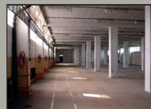
Výrobná hala v priemyselnej zóne v Žiline, 800 m 2 , protipožiarne vybavenie. Hala je strážená SBS-kou.
